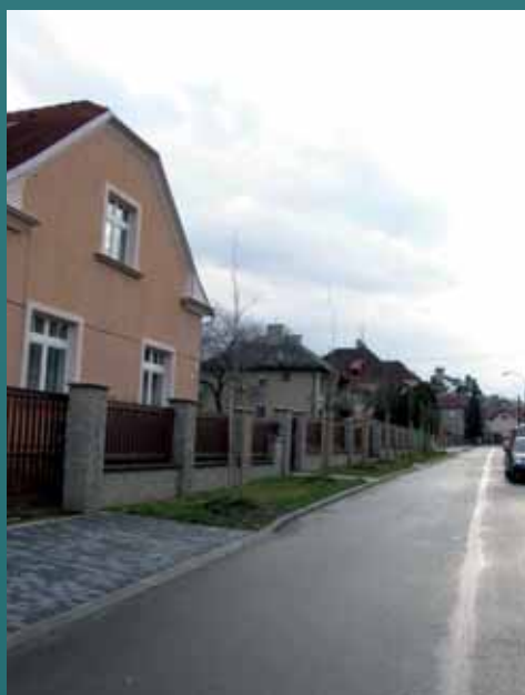
Opravena byla část Štefánikovy ulice
