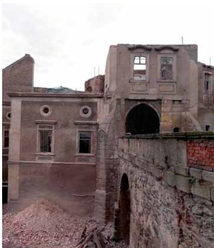
Škvorecký zámek v rekonstrukci, březen 2008
