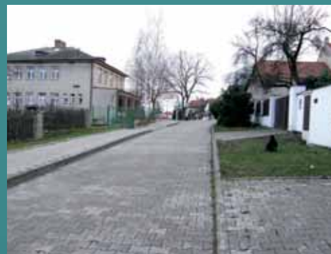
Raisova ulice s novým povrchem
